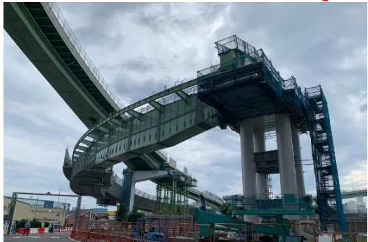
④橋桁の設置
