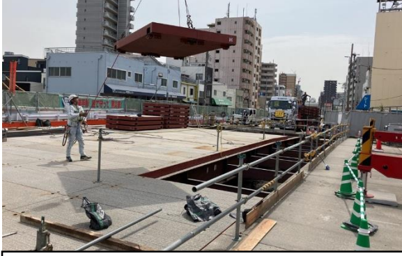
⑥栈橋の覆工設置
