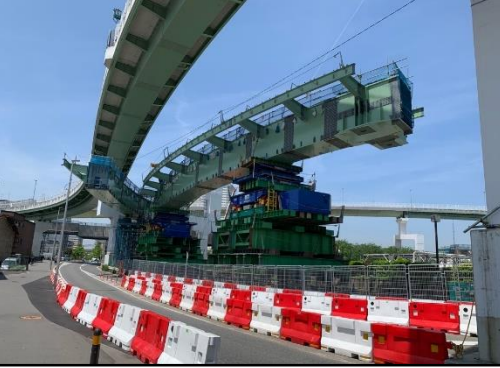
④橋桁の設置
