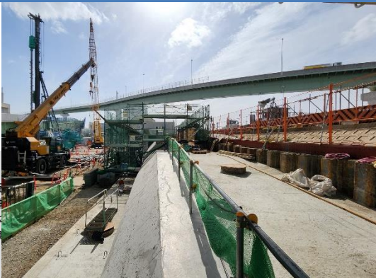
②掘割擁壁部の構築
