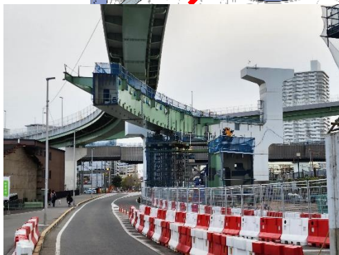
④橋桁の設置
