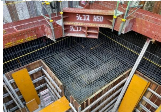
⑤換気所地下部の構築
