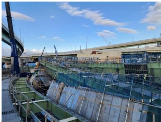
①橋桁の設置
