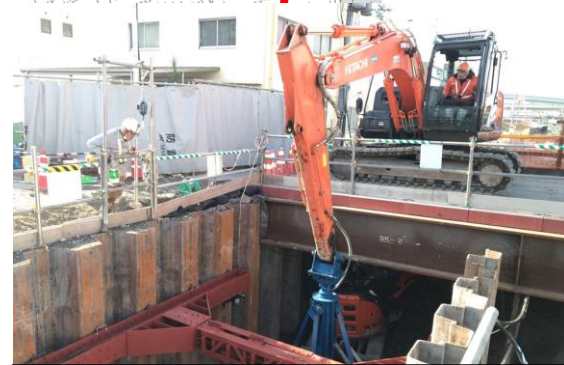
⑥下水移設に係る掘削
