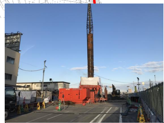
⑥基礎杭の設置
