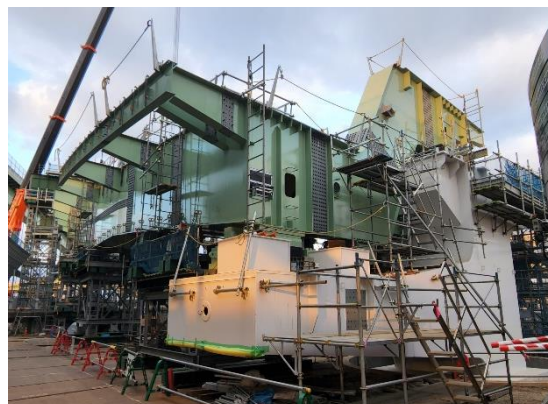
①橋桁の設置
