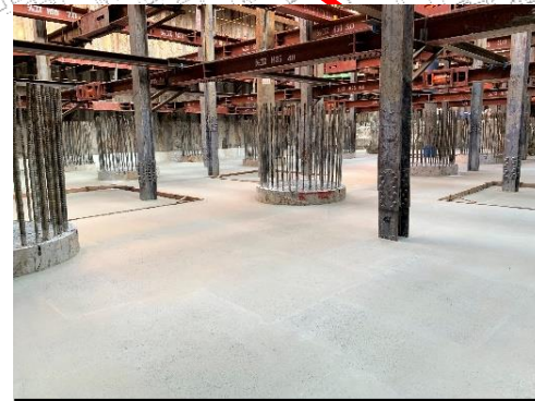
⑥換気所基礎部の構築
