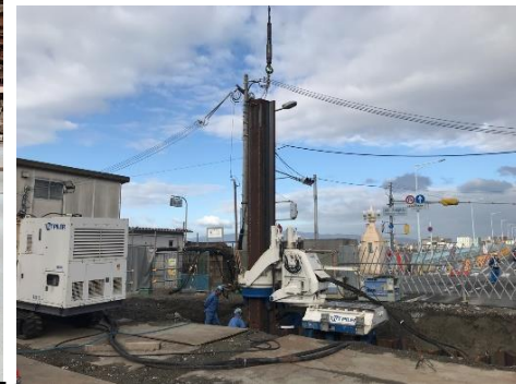
⑦土留め工
