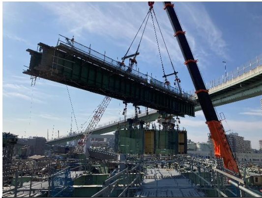
①橋桁の設置
