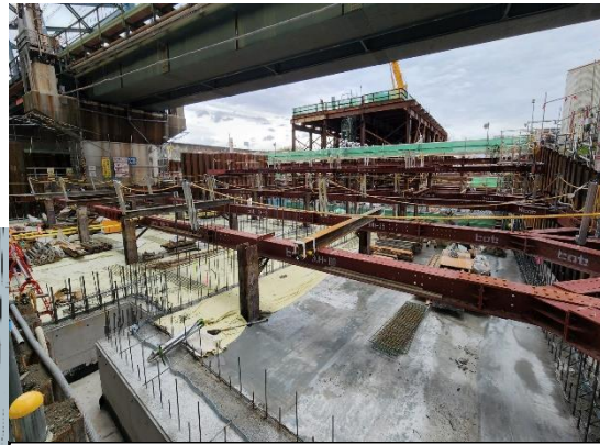
②掘割擁壁部の構築
