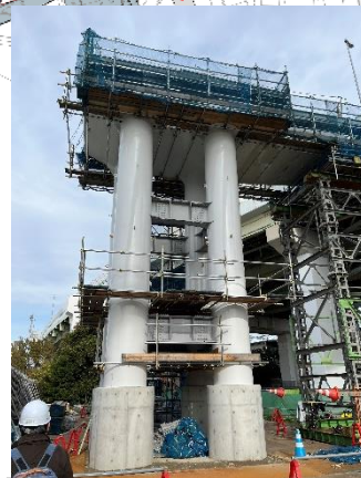
⑤橋脚の設置
