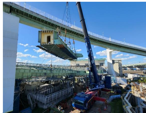
①橋桁の設置
