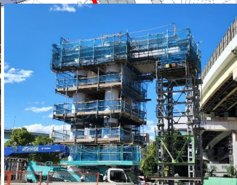
⑤橋脚の設置
