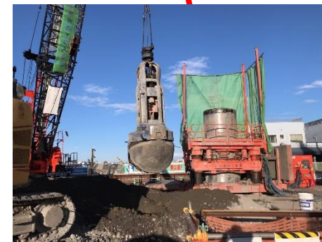
⑦地中障害物撤去
