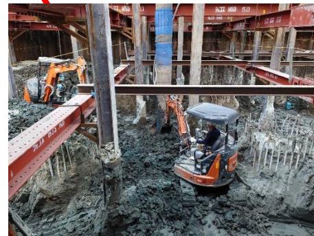
⑥換気所の掘削
