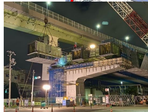
④橋桁の設置
