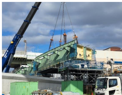
①橋桁の設置
