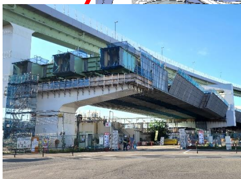
④橋桁の設置
