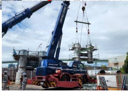
⑤橋脚の設置
