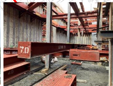
⑥換気所掘削
