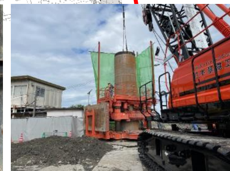
⑦地中障害物撤去
