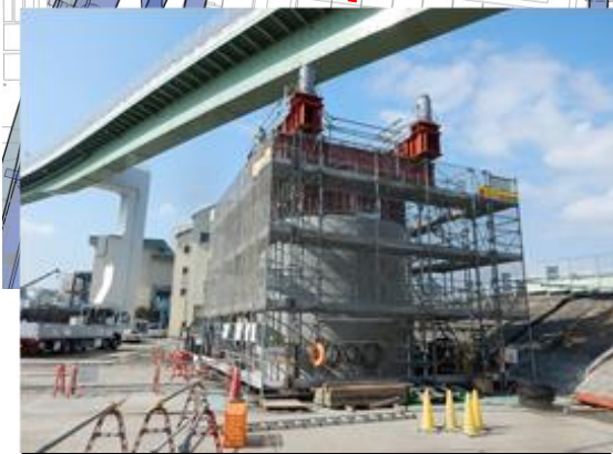
橋梁基礎の構築
