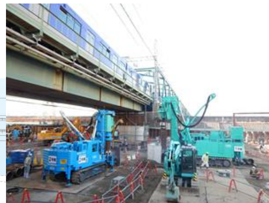
基礎杭の設置
