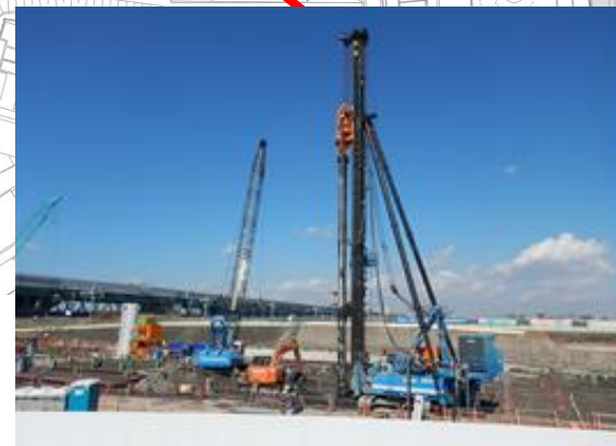
栈橋杭の設置
