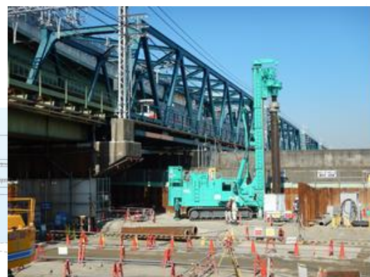
基礎杭の設置
