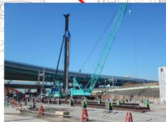
栈橋杭の設置
