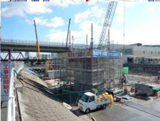
橋梁基礎の構築
