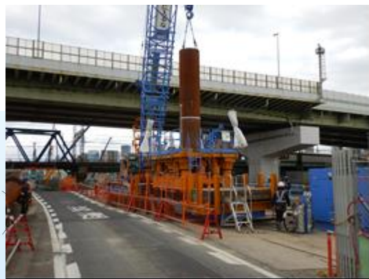
基礎杭の設置
