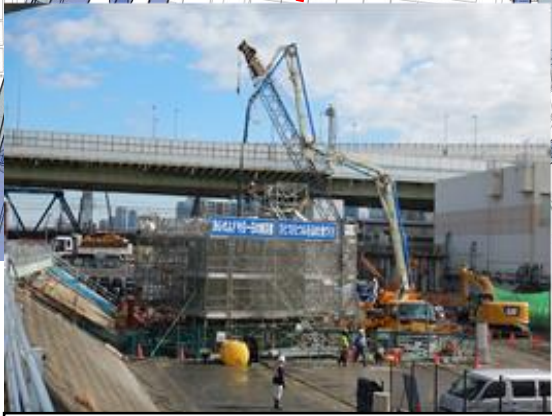
橋梁基礎の構築
