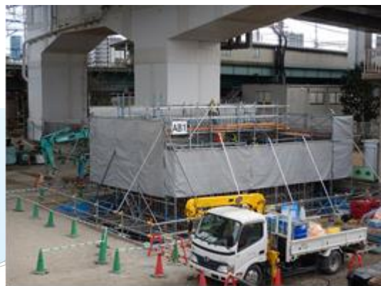
橋台本体の構築
