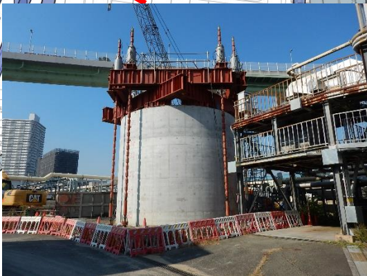
橋梁基礎の構築
