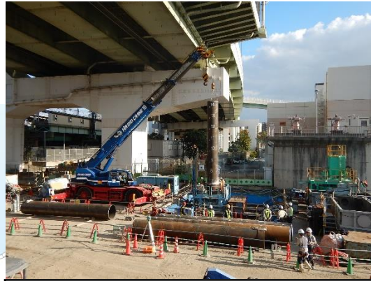
基礎杭の設置
