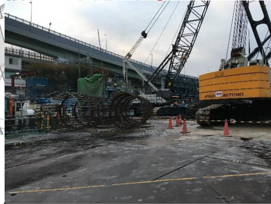
基礎杭の設置
