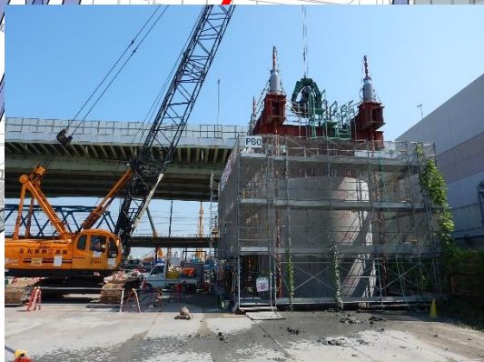
橋梁基礎の構築
