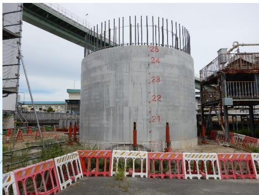
橋梁基礎の構築
