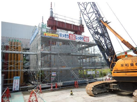
橋梁基礎の構築
