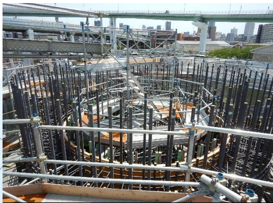
橋梁基礎の構築
