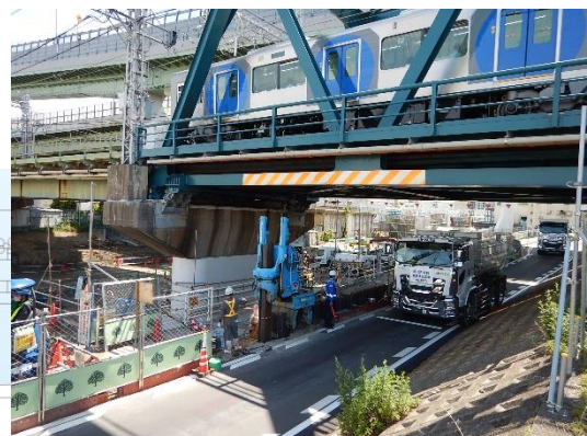
鋼矢板の設置
