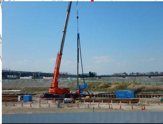
鋼矢板の設置
