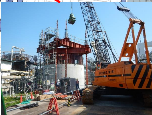
橋梁基礎の構築
