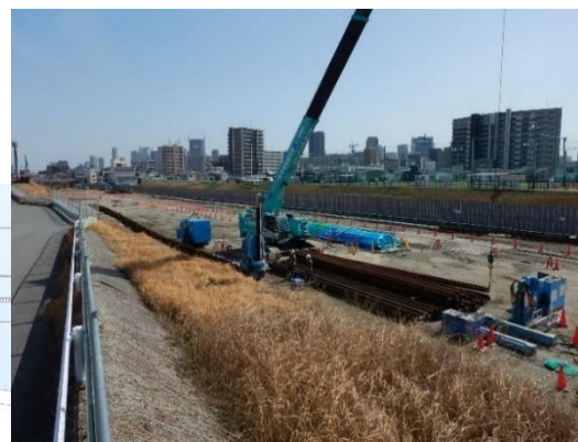
鋼矢板の設置
