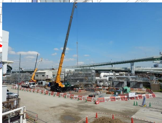
橋梁基礎の構築
