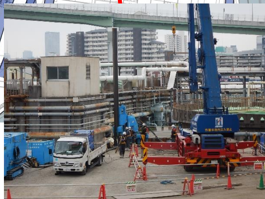
鋼矢板の設置
