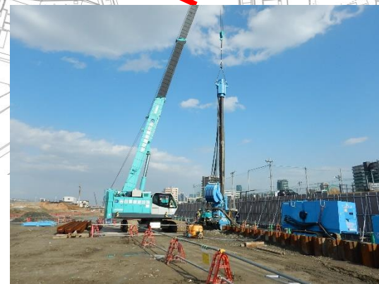
鋼矢板の設置
