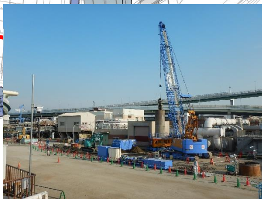
地中障害物撤去
