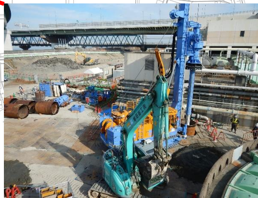
地中障害物撤去
