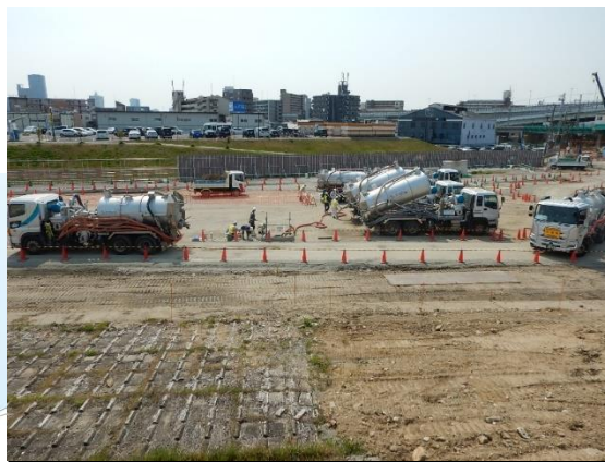
旧下水道の撤去
