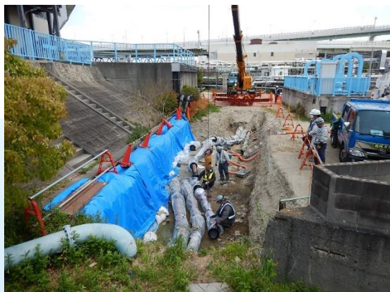
埋設管の移設
