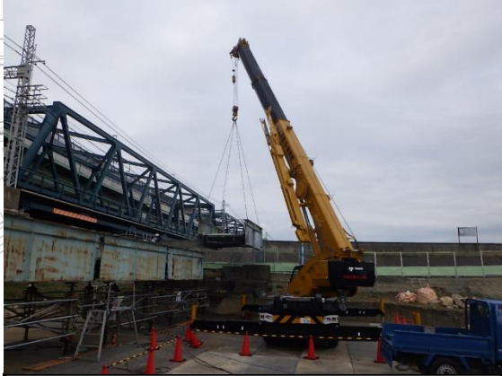
歩道橋の橋桁撤去
