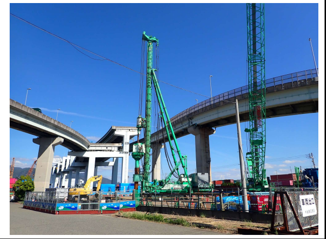
【3】橋脚(PPE-1)基礎工事において、鋼管矢板継手部の先行削孔状況。
