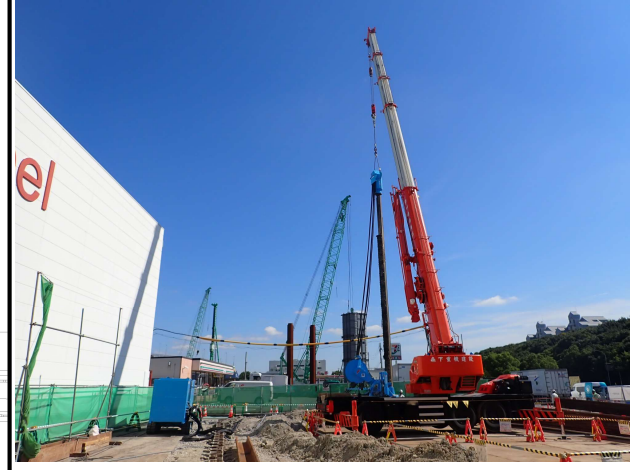
【2】橋脚(PPE-5R)基礎工事において、鋼矢板の打込み(土留支保工の設置)状況。
