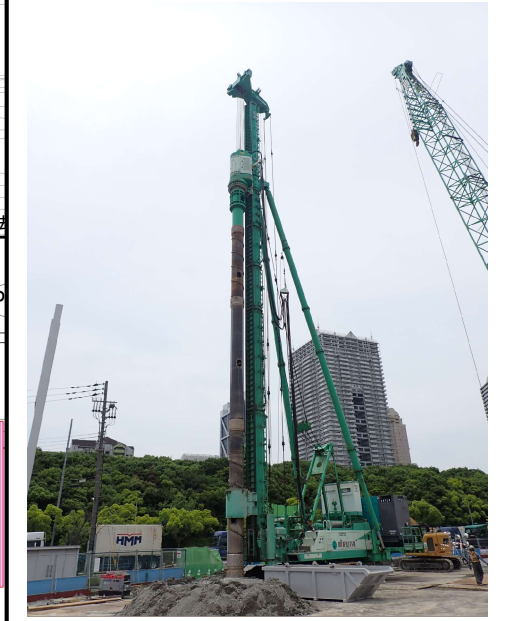
【3】高速道路の橋脚(PPE-4)基礎工事に於いて、鋼管矢板基礎施工前の先行削孔中。
