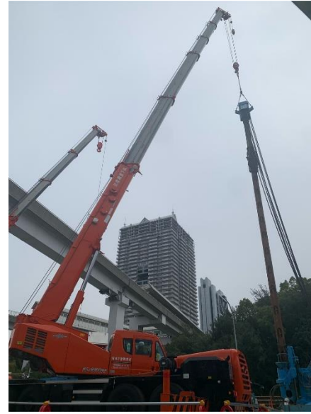
【2】高速道路の橋脚(PPE-7)基礎工事に於いて、影響遮断矢板の設置中。
