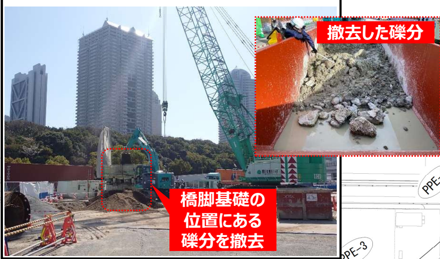
② 高速道路の基礎工事に先立ち、地中に存在する工事に支障となる礫分の事前撤去中。
