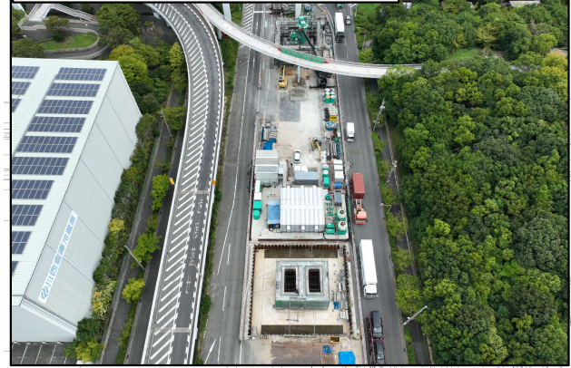
写真① PE-1 橋脚鉄筋組立
