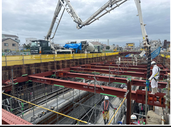
【2】施工区間⑤ U-1ブロック 側壁コンクリート打設状況
