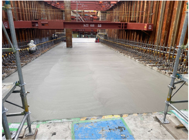
【2】施工区⑤ U-2ブロック 底版コンクリート打設完了
