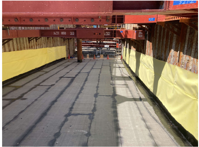
【2】施工区間⑤ B-2ブロック 底部防水完了状況
