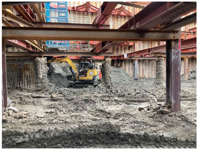
【2】施工区間② 4-2、5-1ブロック 埋戻し状況
