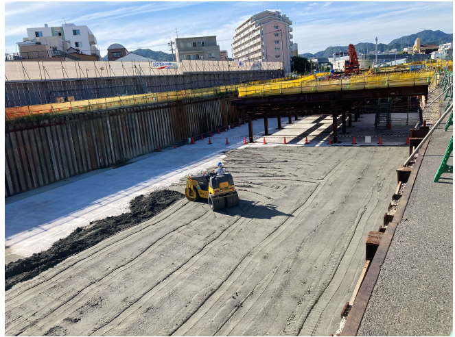
【2】施工区間② 4-2、5-1ブロック 埋戻し状況
