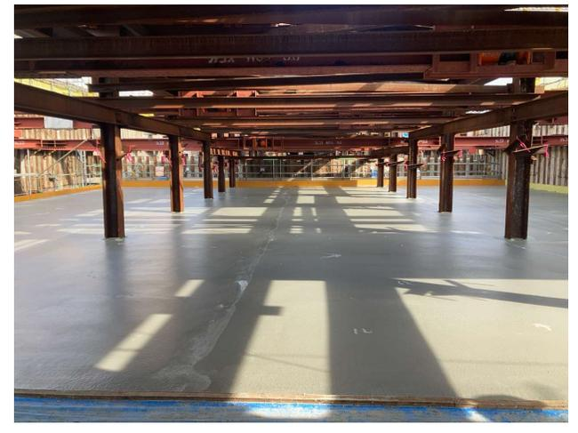
【2】施工区間⑤U-4ブロック底版コンクリート打設完了
