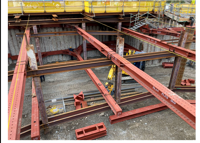
【2】施工区間④の切梁(2段目)設置状況。
