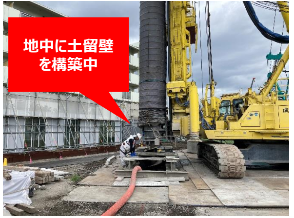
② 地中連続壁工法による土留壁を施工中。
