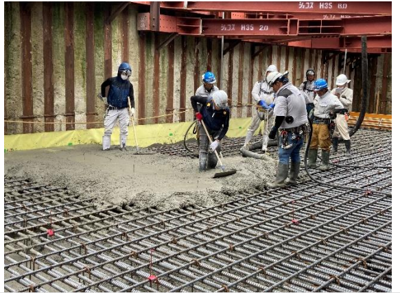
② 地中連続壁工法による土留壁を施工中。
