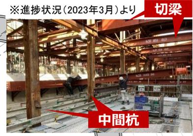
② 中間杭(左写真)の建て込みに向けた先行掘削を実施。
