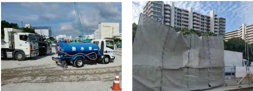
図 5-8 工事中の散水（左）、工事施工ヤードへの仮囲いの設置（右）
