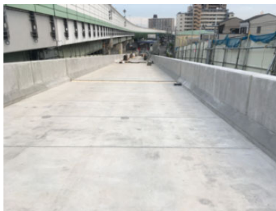
玉出施工完了
