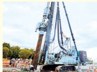
▲杭の打設工事
