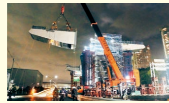
▲梁の組み立て工事
