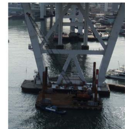
台船を用いたクレーン作業
