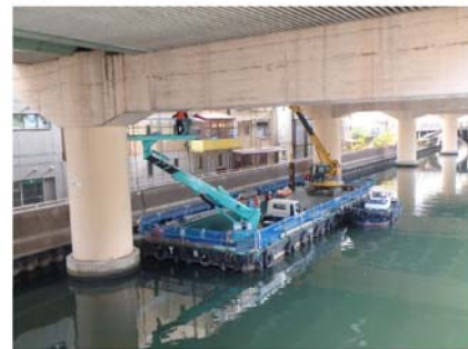
水上橋脚の足場設置事例
