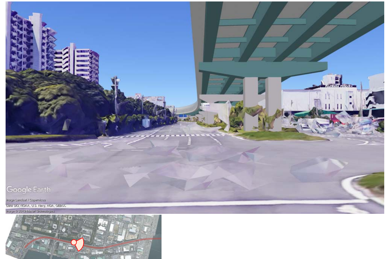
視点⑦ 六甲大橋西交差点
