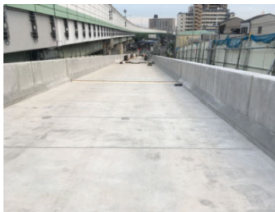
玉出施工完了
