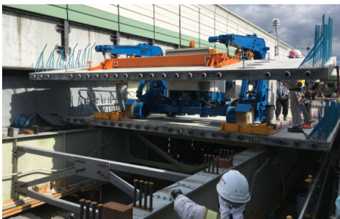
平板型 UFC 床版の架設
