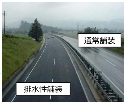
排水性舗装の例
