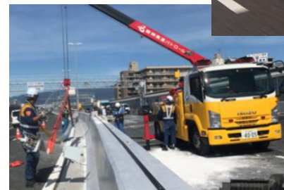
当社機動支援隊レッカー車による事故処理状況
