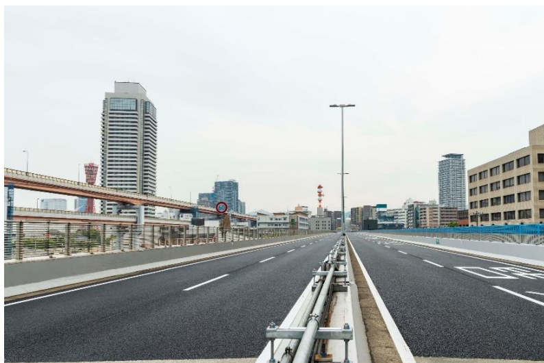
リニューアル工事にて舗装を全面的に打ち替えた例
