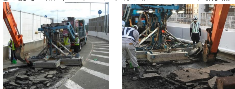
IHを使って鋼床版上の舗装をはがす工法
