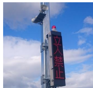
逆走・不法行為 検出警告装置 (6号大和川線鉄砲出口の設置例)
