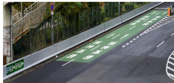
〔カラー舗装による高速入口の明示〕
