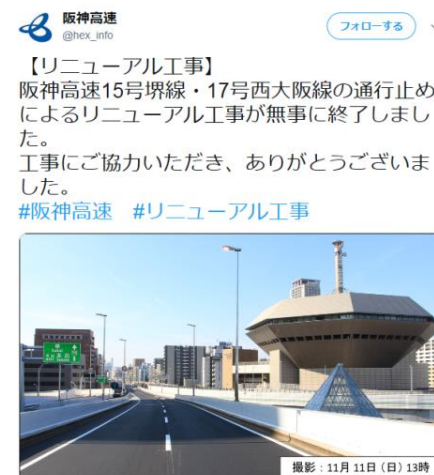
堺線・西大阪線リニューアル工事の完了
