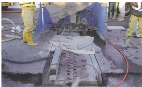
伸縮継手をワイヤーソーで切り取る工法
