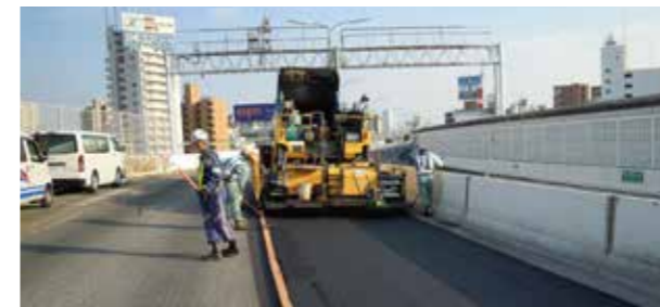
舗装の打ち替え
