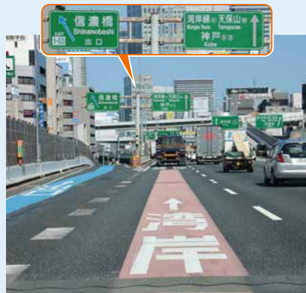
案内標識や舗装に、安全対策を目的としたカラー表示を採用した例 (1号環状線 西船場JCT)
