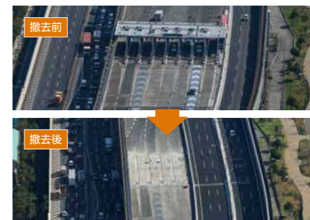
3号神戸線における尼崎料金所の撤去
