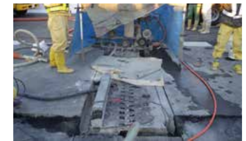
SJS工法による ジョイントの撤去
