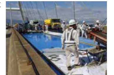
5号湾岸線リニューアル工事
