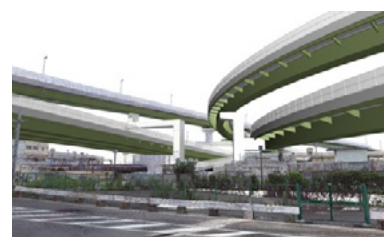
ジャンクション建設におけるCIM活用事例
