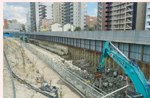
地中障害物撤去工(豊崎地区)
