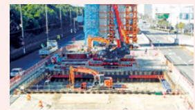
基礎工 (六甲アイランド地区)
