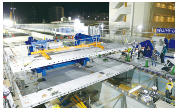
コンクリート床版の取替
