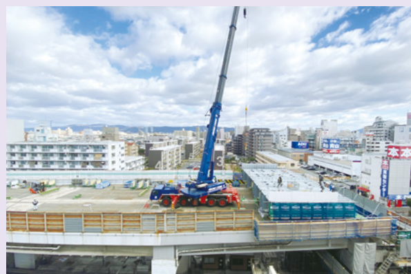
大規模更新工事(喜連瓜破付近)
