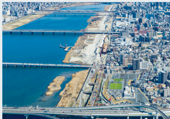
淀川の堤防沿いにトンネル構造で建設中の淀川左岸線(2期)
