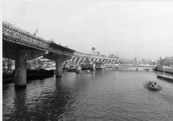
堂島川に建設中の環状線(中之島周辺)
