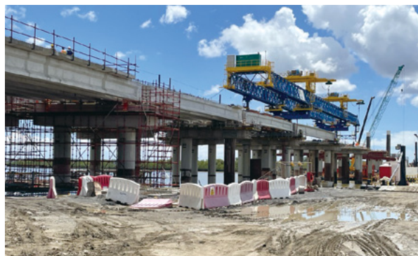
建設中のモンバサ南バイパス(ケニア)
