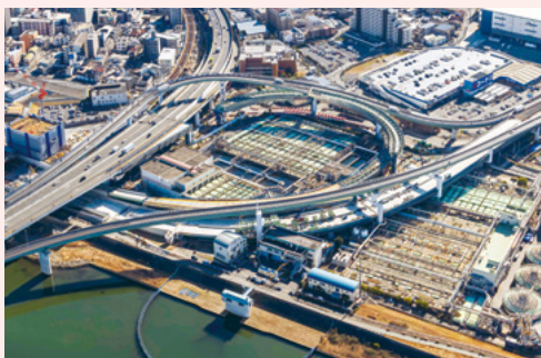
工事進捗状況(海老江地区)
