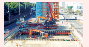
基礎工(六甲アイランド地区)
