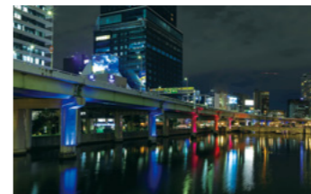
中之島エリア橋脚 ライトアップ
