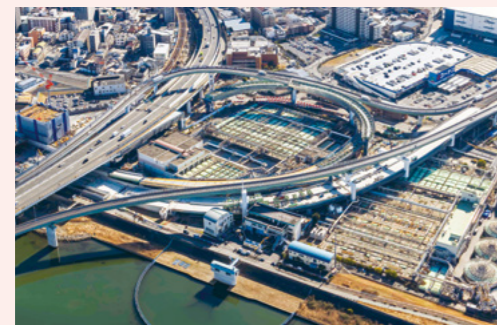
工事進捗状況(海老江地区)
