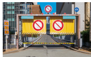
入口遠隔閉鎖装置
