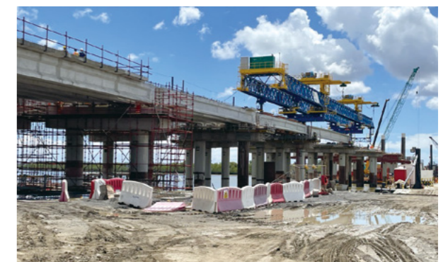
建設中のモンパサ南バイパス(ケニア)
