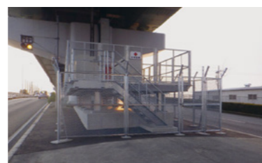
変電塔のかさ上げ
