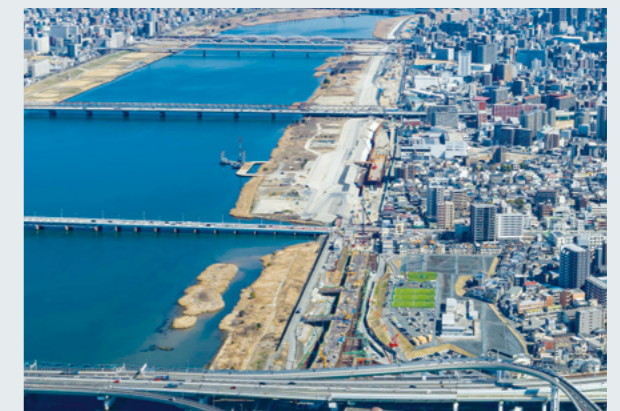
淀川の堤防沿いにトンネル構造で建設中の淀川左岸線(2期)
