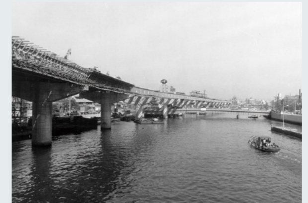
堂島川に建設中の環状線(中之島周辺)
