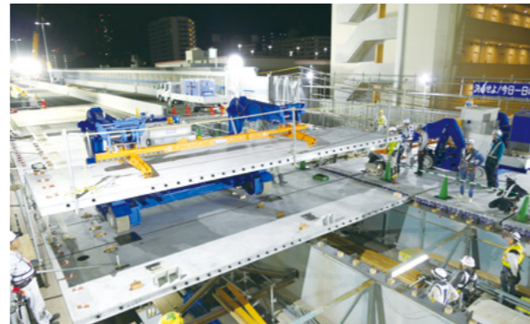
コンクリート床版の取替
