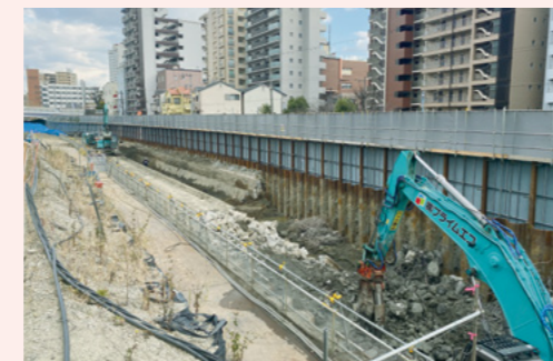
地中障害物撤去工(豊崎地区)
