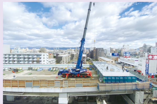
大規模更新工事(喜連瓜破付近)
