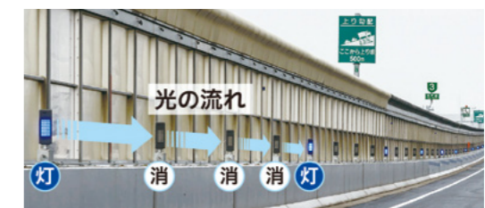
速度回復誘導灯(3号神戸線(東行)深江付近)
