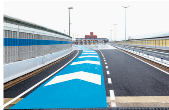
本線料金所の交通分散を図るカラー舗装
