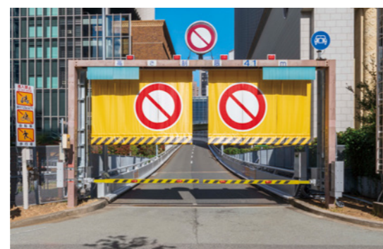
入口遠隔閉鎖装置（中之島入口）
