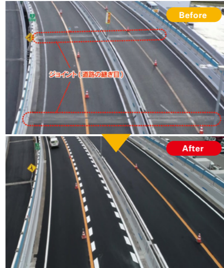
ジョイントレス工事前後
