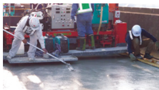
SFRC舗装施工
