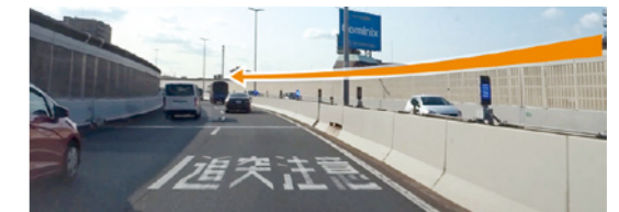
11号池田線(南行)塚本合流付近における速度回復誘導灯の設置
