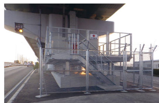
変電設備のかさ上げ
