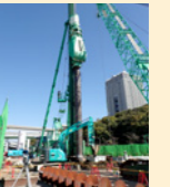
基礎工(六甲アイランド地区)
