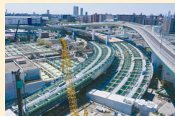
橋梁架設工(海老江地区)
