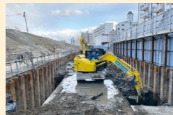
地中障害物撤去工事(豊崎地区)
